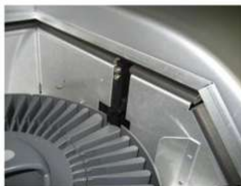
Figure 2 オートローダーが正しく収まっている様子
